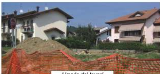
L'avvio dei lavori
