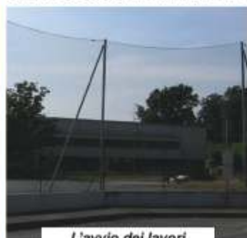
L'avvio dei lavori
