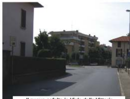
Il nuovo asfalto in Viale delle Vittorie
